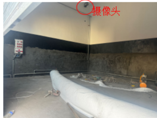
COD及氨氮分析残液暂存间（施工期）
