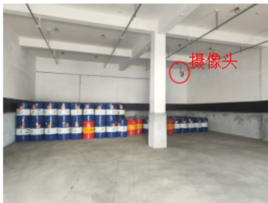
废油桶暂存间
