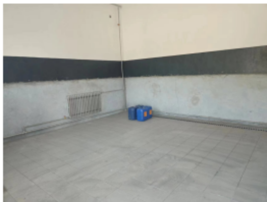
COD及氨氮分析残液暂存间
