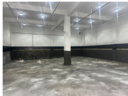
废油桶暂存间（施工期）
