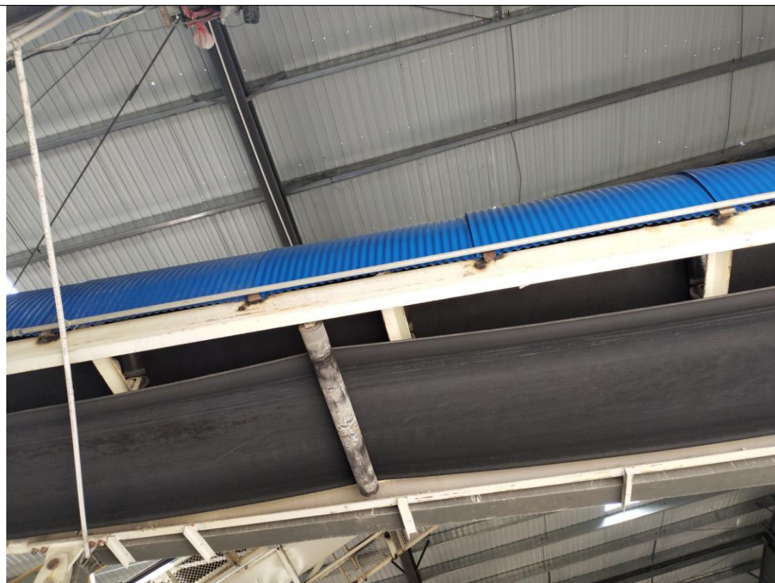
上料系统封闭廊道
