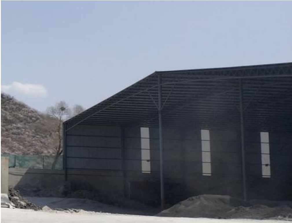
半封闭原料堆场
