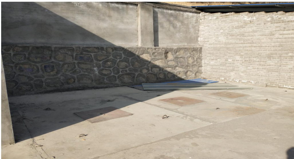
生产区化粪池
