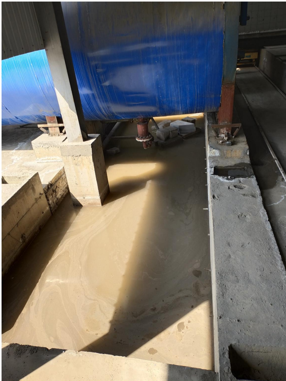
蒸压釜下方冷却水收集池
