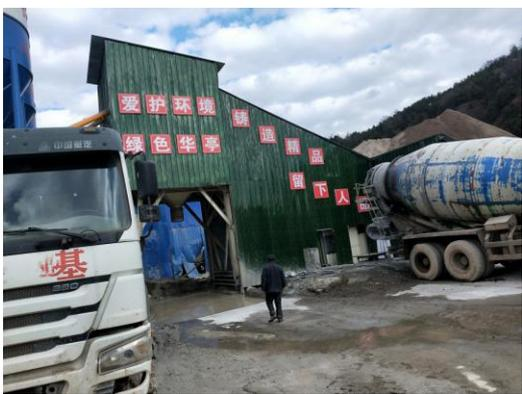
全封闭混凝土拌合站
