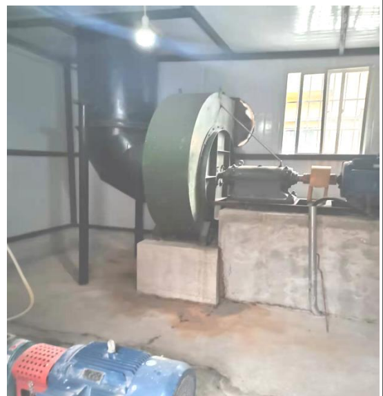
引风机安装隔声罩
