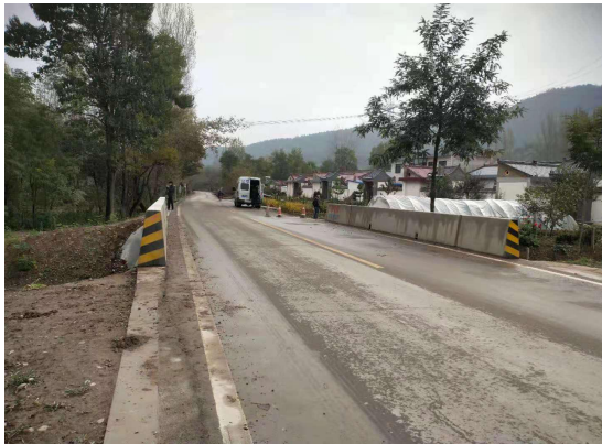
改造后桥梁现状（北侧临高速公路）
