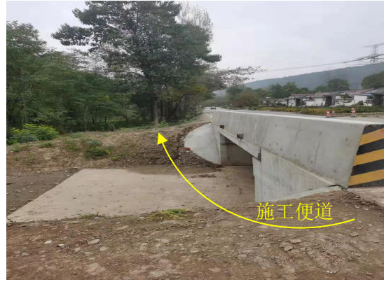
恢复后施工便道及改造后桥下现状
