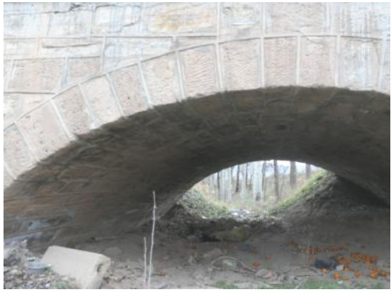
原有桥梁现状照片
