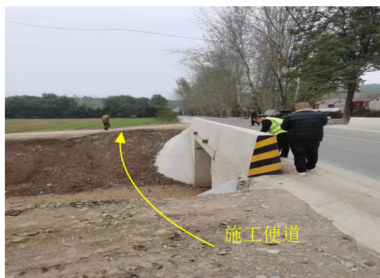
恢复后施工便道现状
