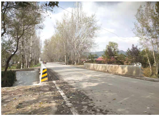
改造后的桥面现状
