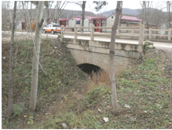
原有桥梁现状照片
