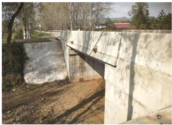
改造后的桥下现状
