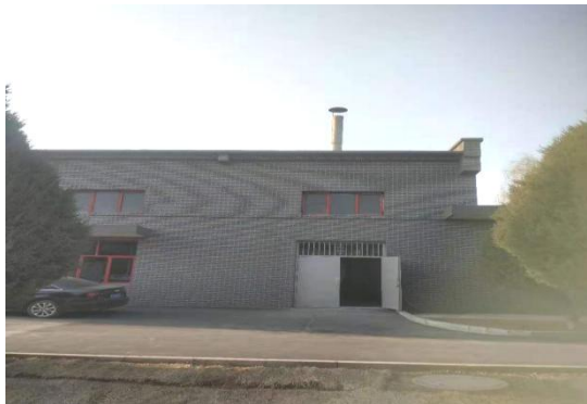
锅炉房外观（排气筒）
