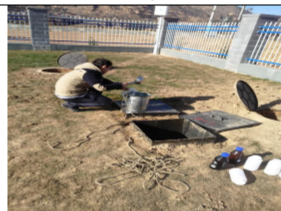
污泥池及清水池
