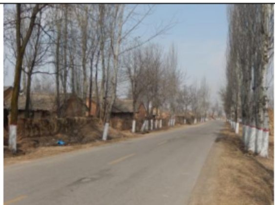
开挖恢复后道路
