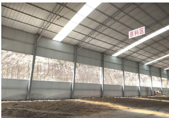
封闭厂房及原料区
