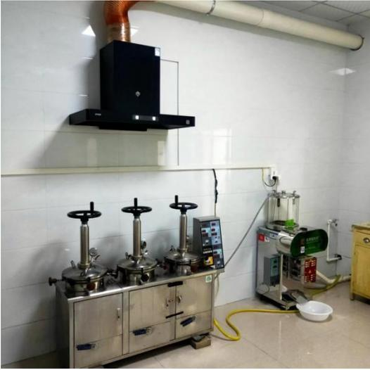
图 7 熬药间废气处理装置
