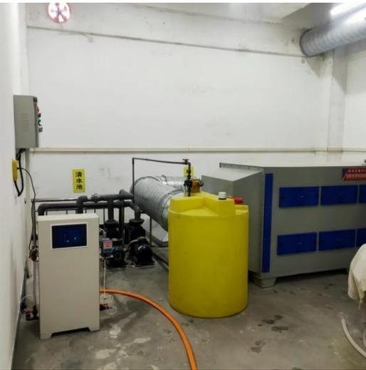
图 8 污水站加药装置
